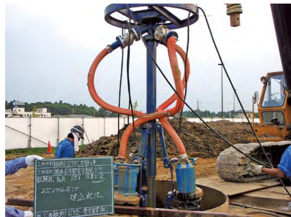
専用スライム処理機使用状況 (軸径φ2,100、拡底径φ4,700)
